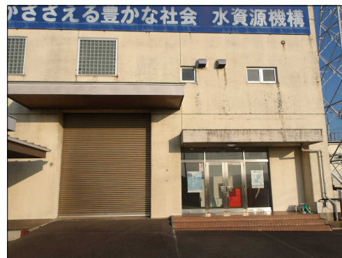
東庄揚水機場 シャッター
